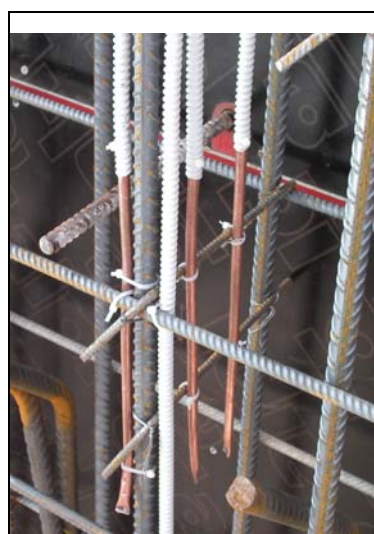
Figura 8 - Particolare disposizione sonde e loro alloggi
