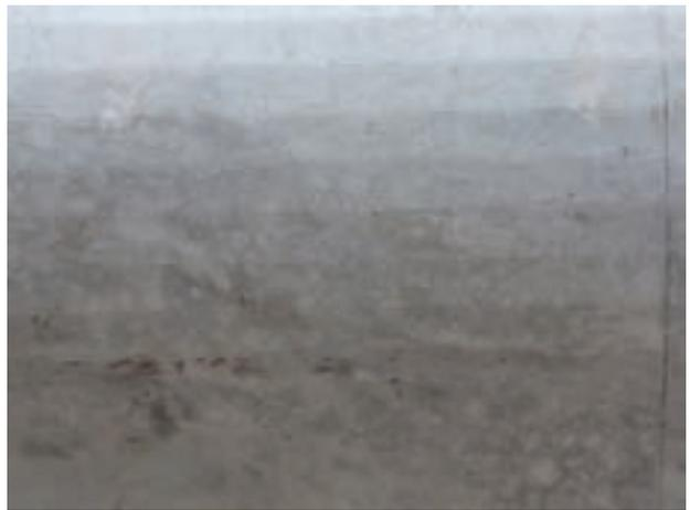
Fig. 6 - Cavillature da espansione termica su superficie contro cassero.
